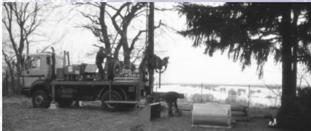
Bereits im Januar 2003 fanden die Probebohrungen für die Gründung des Besucherinformationszentrums auf dem Elbberg statt. Hier kann nun 2004 die Ausstellung in Form einer Elbbrücke gebaut werden.
