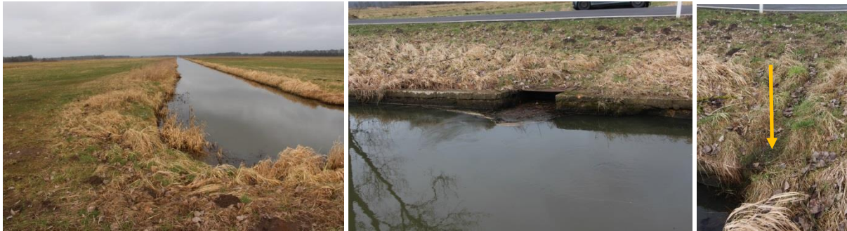
Abb. 13: Habitat 1355-006, Entwässerungsgraben östlich des Simmergrabens, Gewässer-Straßen-Kreuzung (m.) und Wechsel mit Fischotterlosung (re.) (Fotos: GNL, 2017)
