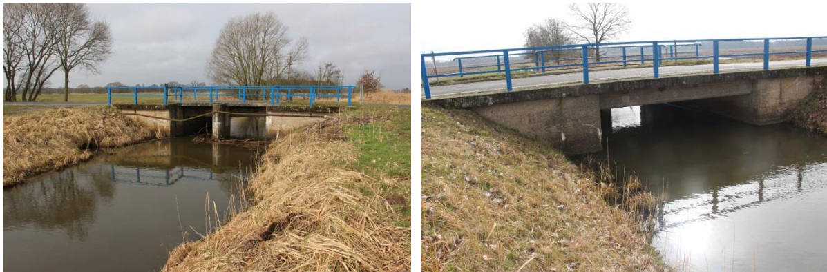
Abb. 12: Habitat 1355-004, Straßenbrücke der L061 über den Simmergraben (li. und re.) (Fotos: GNL, 2017)
