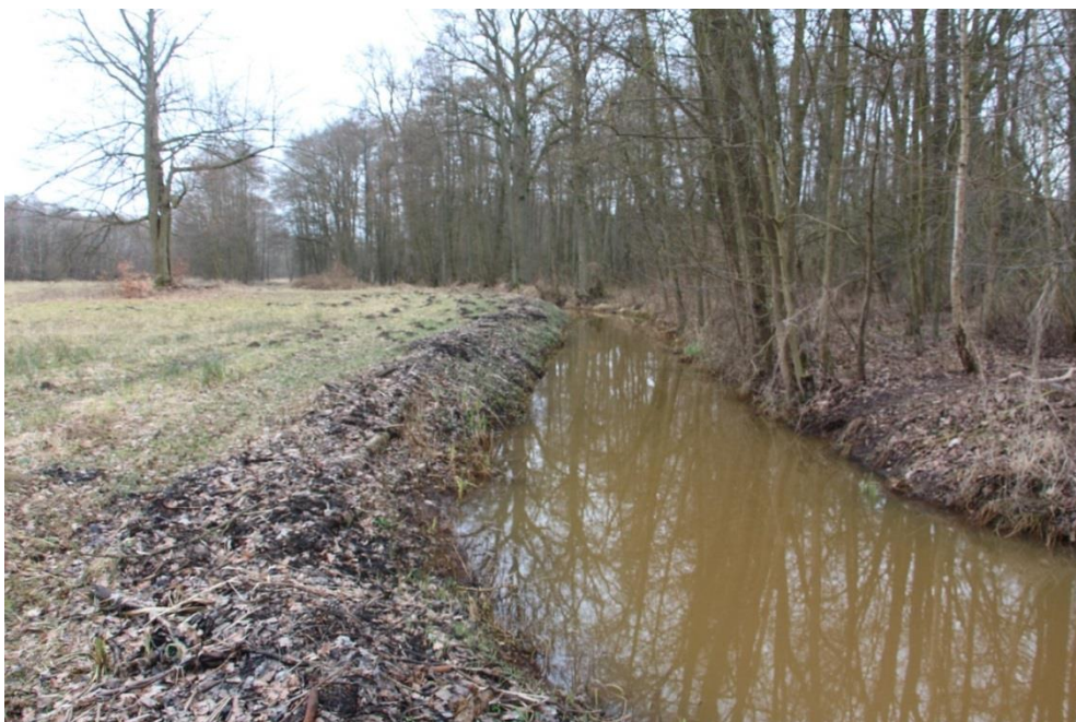
Abb. 10: Habitat 1355-001 Räumgut einer Sohlkrautung mit Sedimententnahme am Bohldammgraben bei Bohldamm (Fotos: GNL, 2017)
