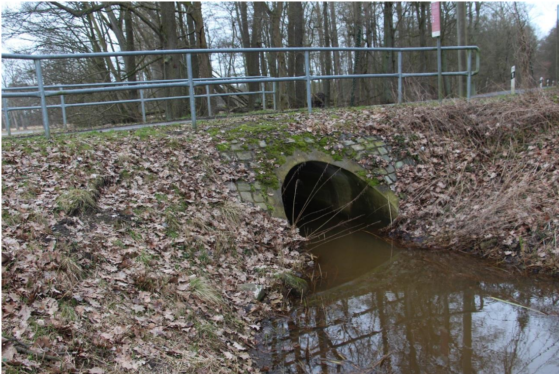
Abbildung 3: Gewässer-Straßen-Kreuzung am Bohldammgraben bei Gudow
