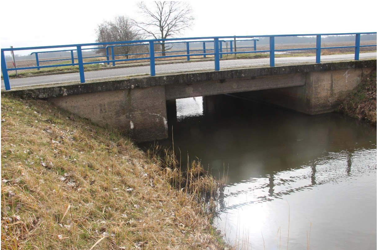
Abbildung 9: Straßenbrücke der L061 über den Simmergraben
