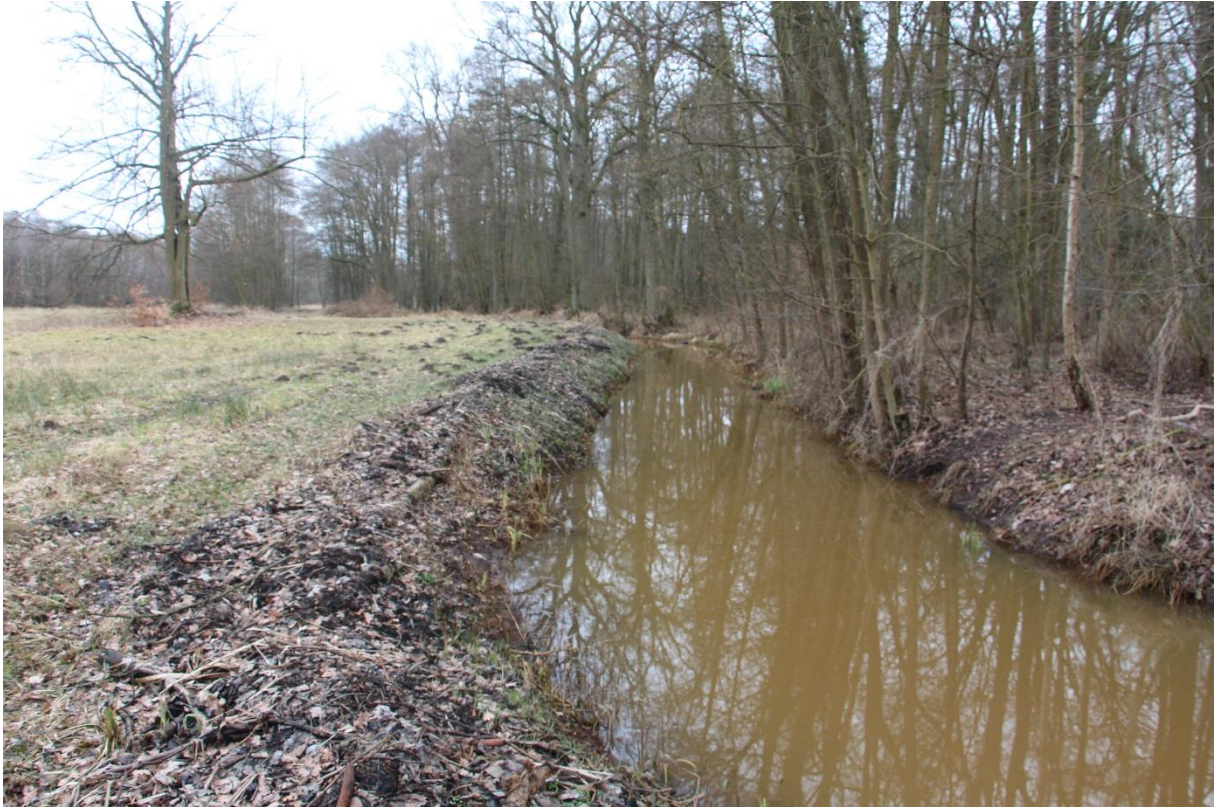
Abbildung 4: Räumgut einer Sohlkrautung mit Sedimententnahme am Bohldammgraben bei Bohldamm
