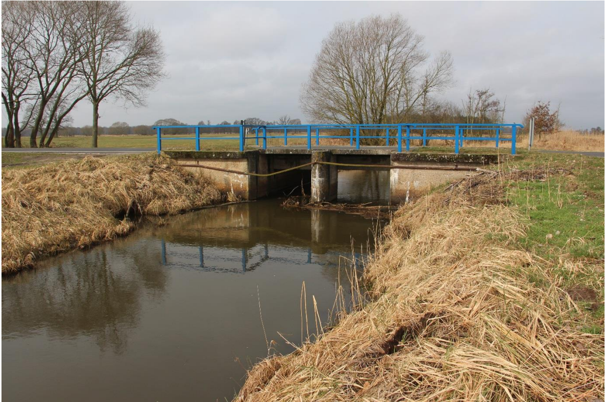
Abbildung 8: Straßenbrücke der L061 über den Simmergraben
