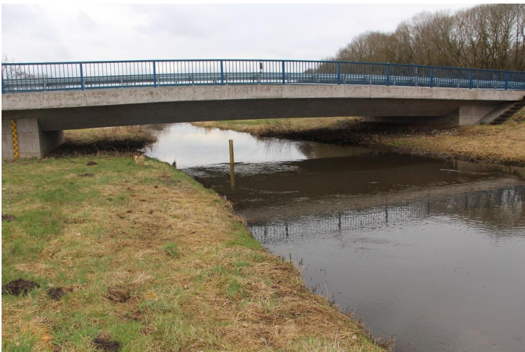
Abbildung 6: Straßenbrücke der L061 über Rögnitz
