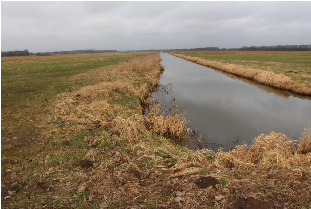
Abbildung 11: Entwässerungsgraben östlich des Simmergrabens
