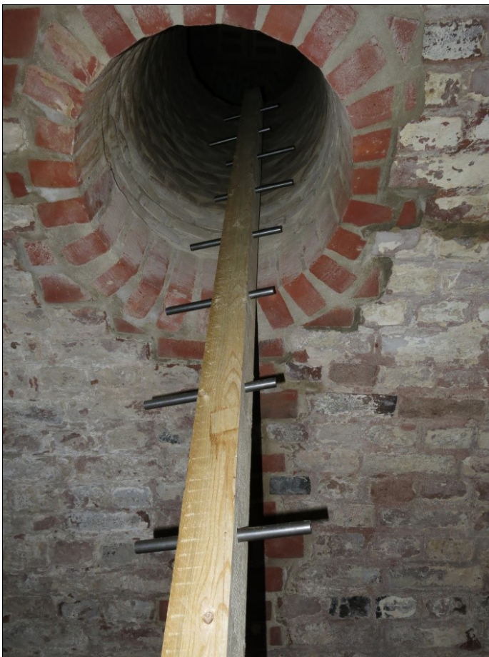
Abbildung 8: Zugang zu einer Gewölbekammer mit montierter "Spezialleiter".
