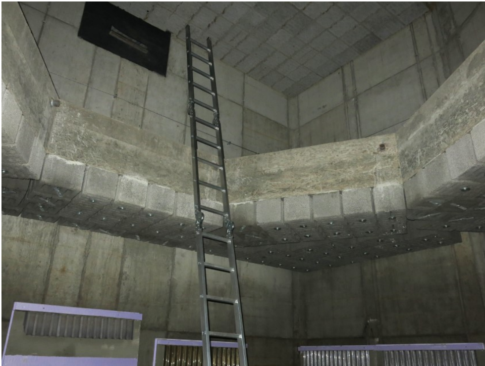
Abbildung 7: Blick in den "Neubau" der über zwei Etagen verläuft und eine Gesamthöhe von ca. 7 m aufweist. An den Decken wurden nahezu 700 Quartiersteine montiert. Der monolithische Bau befindet sich derzeit noch in der Phase der "Klimatisierung".
