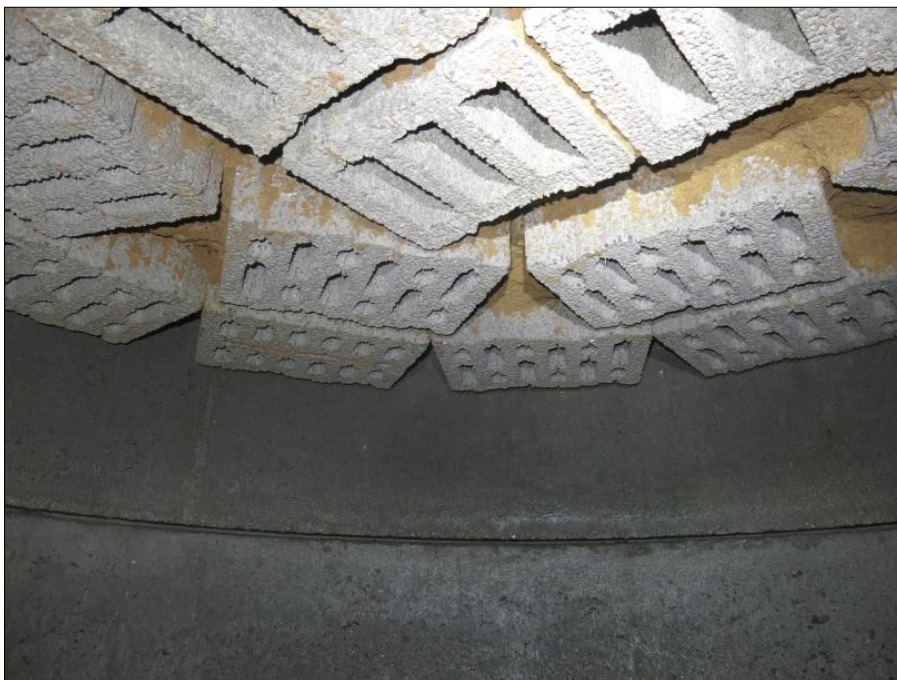
Abbildung 9: Blick in eine Gewölbekammer, bestehend aus größeren Brunnenringen und Quartiersteinen, die in die Deckenkonstruktion eingegossen wurden.
