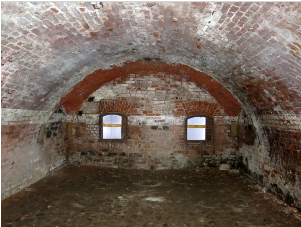
Abbildung 14: Mit Styrodurplatten verschlossene Schießöffnungen in der Bastion "Burg". Der Verschluss erfolgte als CEF-Maßnahme im Rahmen der Sanierung der Bastion "Greif" und wurde zwischenzeitlich wieder zurückgebaut.
