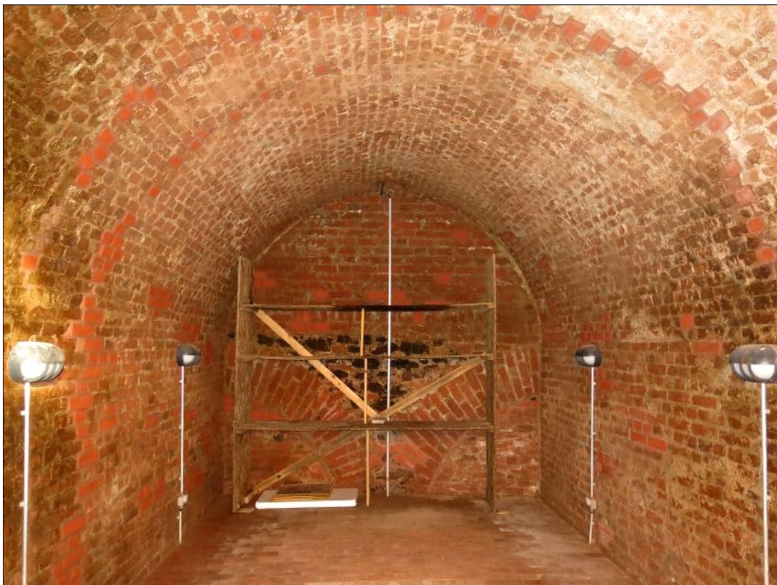
Abbildung 18: Blick in einen der weitestgehend ungenutzten Räume des "Heizungskellers". Die Deckenhöhe und das noch vorhandene feuchte Klima bieten gute Voraussetzungen für die Ansiedlung des Großen Mausohrs.
