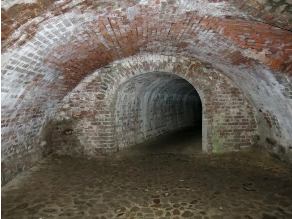
Abbildung 13: Bastion "Burg" - Verbindungsgang zwischen den beiden Kasematten.
